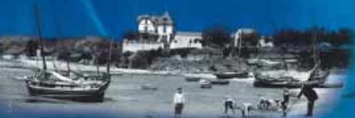
La plage sud connaît une activité importante de construction et de réparation des chaloupes
